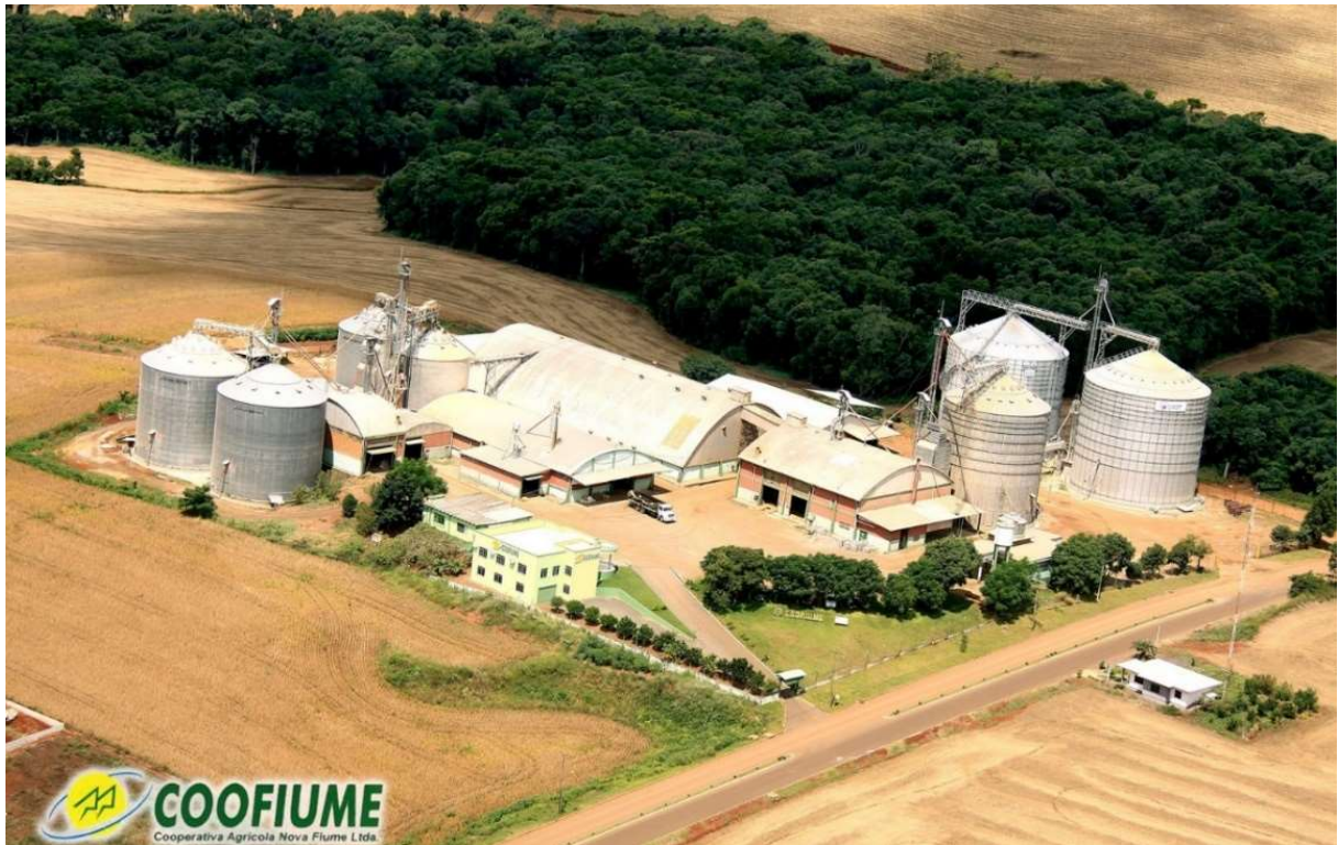
Figura 6 – Vista aérea da COOFIUME Fonte: COOFIUME, 2024.
